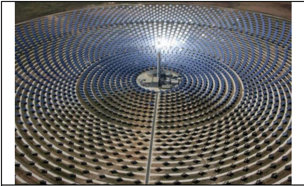
Іспанія. Сонячна електростанція Gemasolar Power Plant (20 MWt)
